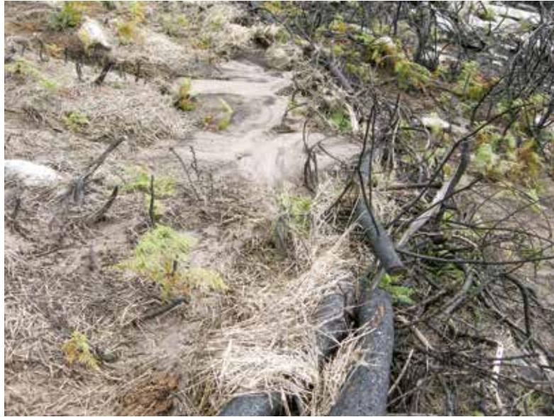
Figura 40. Vista de una barrera colmatada y rebosada por los sedimentos en el incendio de Cures (2010). Nótese en primer término la paja añadida en los huecos para favorecer la retención de sedimentos. Al fondo puede verse que parte de ese material de las barreras más altas fue removido por el agua y depositado más abajo.
