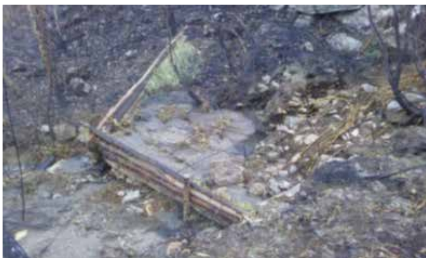
Figura 52. Barreras de troncos colmatadas de sedimentos en un cauce temporal
